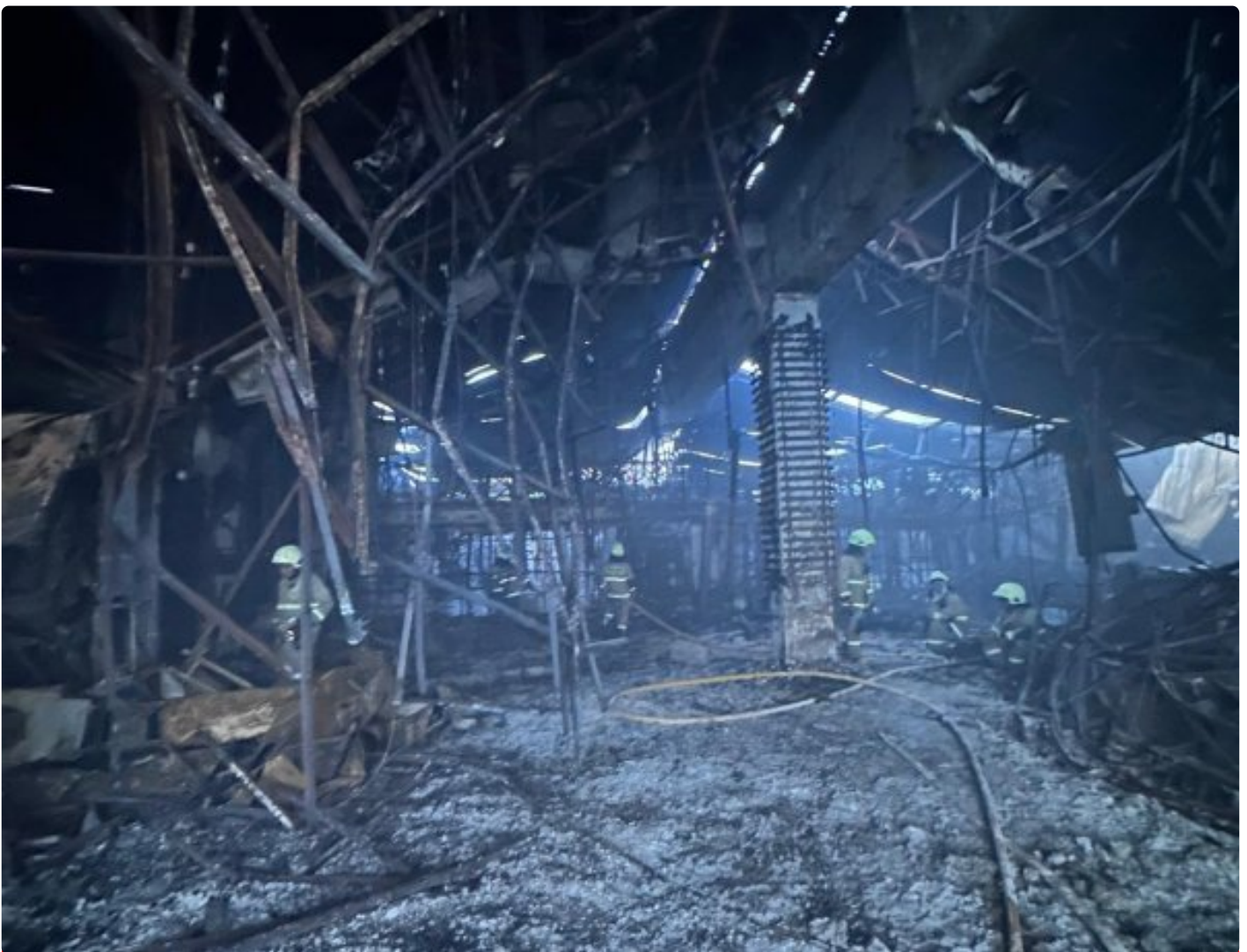
Glodok Plaza yang Hangus Terbakar
